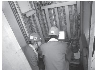
图三、深入电控柜检查测试
